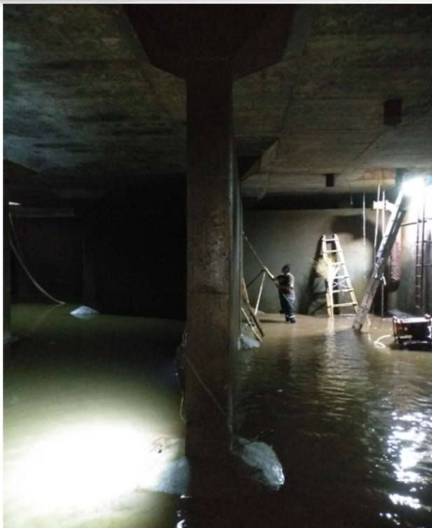
蓄水池排水及池壁清洗
