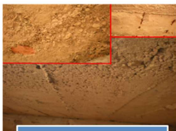
改造前水箱內頂部
