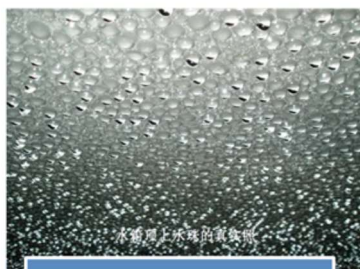
改造后水箱內頂部
