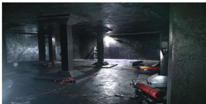
滚涂施工完毕
