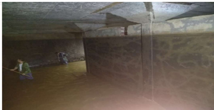
蓄水池排水及池壁清洗
